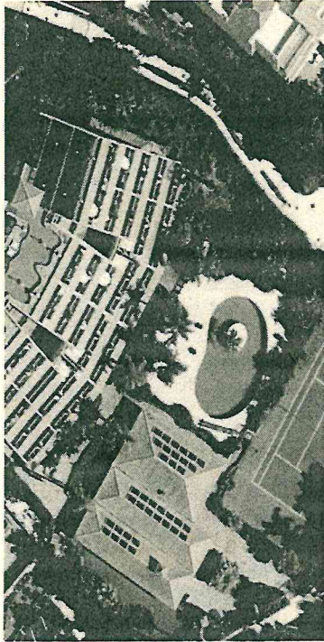
Imagen de la instalación fotovoltaica en autoconsumo de 8,64 kWp en Tigaiga Suites.
